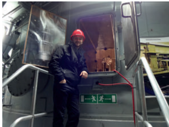
Ein Blick in die offene Luke zum Reaktorkern (ohne Kernbrennstoffe)
