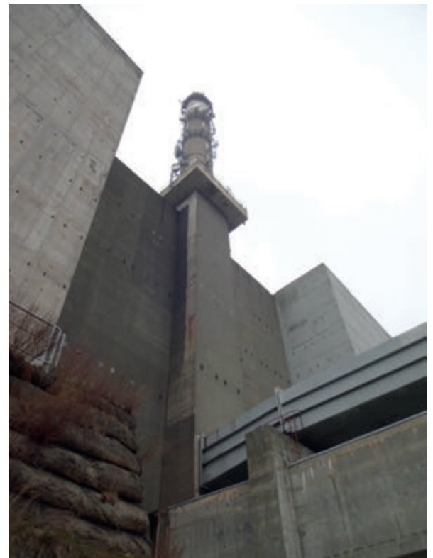
Ein 50 Meter hoher Betonkasten umschließt den Reaktor
