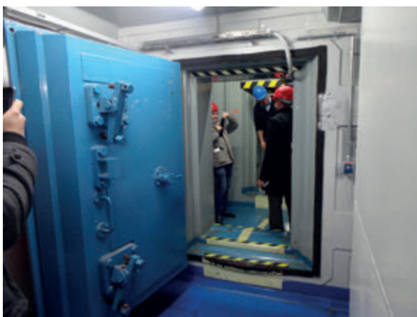
Starke Stahltüren verschließen die meterdicke Betonhülle um den Reaktor
