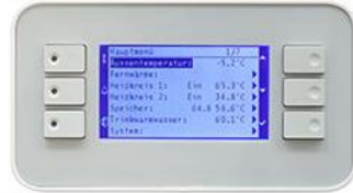
Regler an Wärmeübergabestation 1
