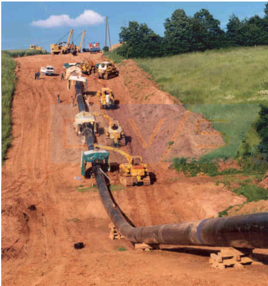
Abbildung 35: Baustelle – Verlegung einer Erdgastrasse in Deutschland
