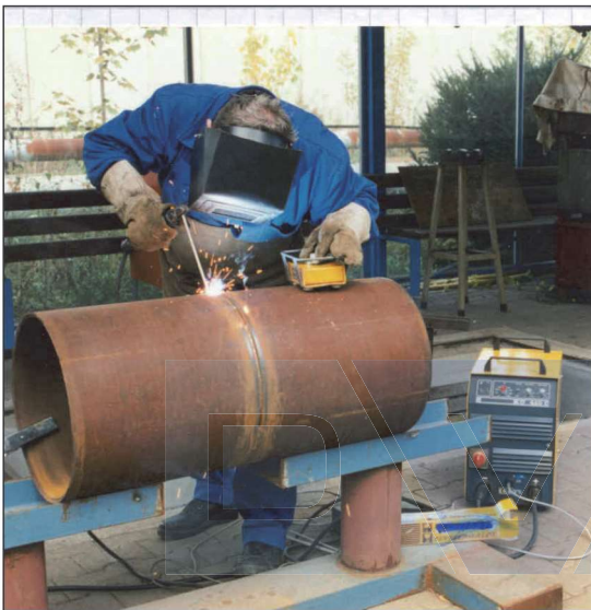
Abbildung 4: Lichtbogenhand-Fallnahtschweißen im Freien
