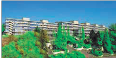
Hauptgebäude in Bergedorf
